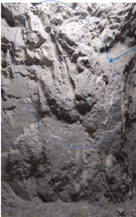
Foto 1- Foto 2: Situazione tipica dello stato di fratturazione degli affioramenti in sotterraneo. Le fratture sono limitate alla presenza di joint sub verticali di modesta persistenza (circa 1.5 m) ed alla presenza di superfici con direzione ortogonale all'andamento dei cameroni.
