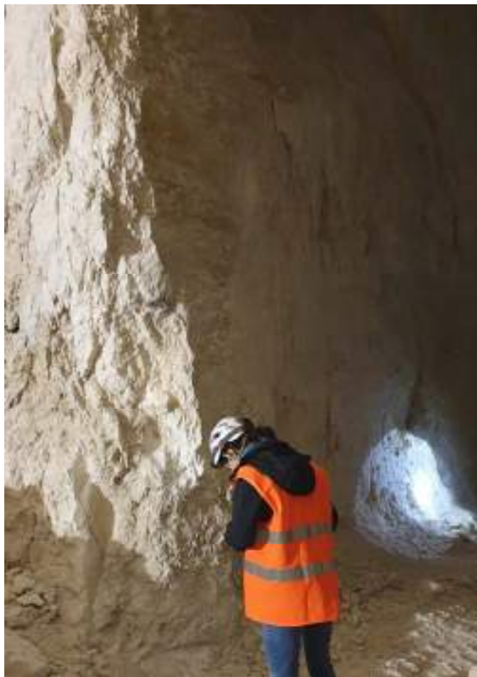
Foto 4: Specchio di frattura ad andamento ortogonale alla direzione delle gallerie di sottolivello
