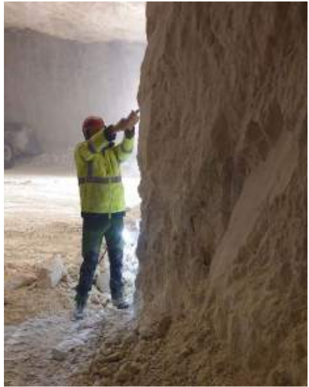
Foto 1- Foto 2: Situazione tipica dello stato di fratturazione degli affioramenti in sotterraneo. Le fratture sono limitate alla presenza di joint sub verticali di modesta persistenza (circa 1.5 m) ed alla presenza di superfici con direzione ortogonale all'andamento dei cameroni.
