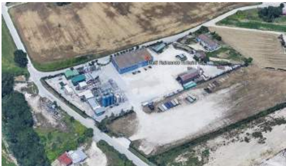
Figura 4-1: Impianto Eredi Bufarini S.r.l., foto aerea
