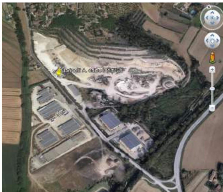
Figura 3-2: Marinelli A. Calce Inerti Srl, foto aerea della Cava in Località Monte Petroso (Perugia)
