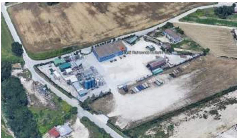
Figura 4-10: Impianto Eredi Bufarini S.r.l., foto aerea
