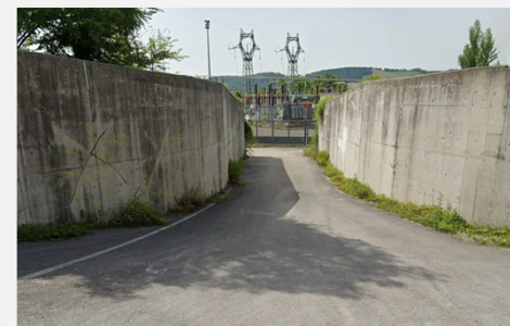
VIA LAMBERTO CORSI/ PODERALE/PISTA DI CANTIERE
