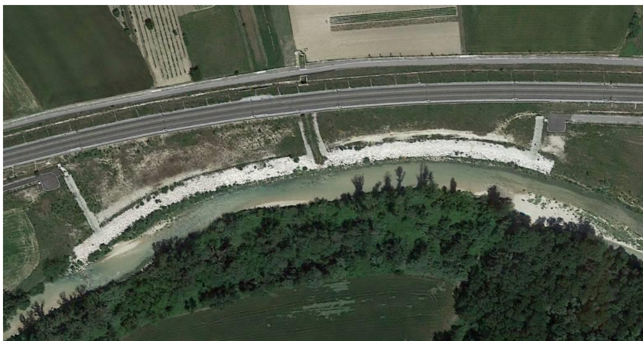
Fig. 18 – Tratta Castelplanio-Montecarotto: opere di sistemazione spondale realizzate sul Fiume Esino.
