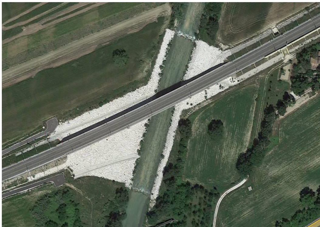
Fig. 17 – Tratta Castelplanio-Montecarotto: opere di protezione realizzate in corrispondenza dell'attraversamento del F. Esino.
